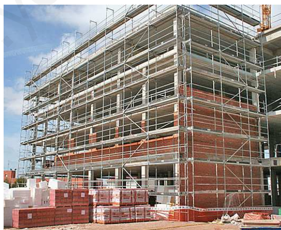
Andamio de construcción.
