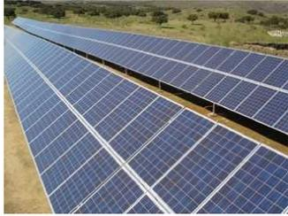
Las células fotovoltaicas están fabricadas con varias capas de distintos materiales, incluyendo **semiconductores** (como el silicio y el germanio). En cada célula se genera un pequeño voltaje.
