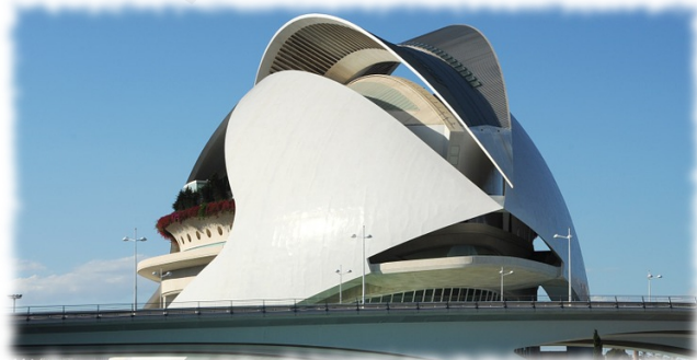
Fig 31: Cubierta del Palacio de las Artes Reina Sofía (Valencia).
