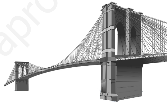
Fig 9: Puente colgante de Brooklyn (Nueva York, EEUU)
