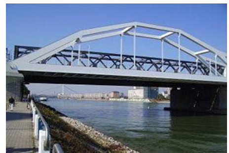
Puente fabricado de acero
