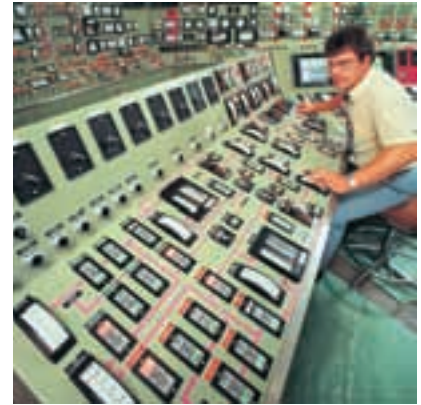
10.20 Aunque la sala de control de una central nucleoelectrónica es muy compleja, el principio físico en el que se basa el funcionamiento de la central es sencillo: parte de la energía en reposo de los núcleos atómicos se convierte en energía térmica, con la cual se produce vapor de agua para impulsar generadores eléctricos.
