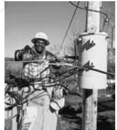
FIGURA 6-22 Reparación de un transformador de bajada en un poste de transmisión de alto voltaje.
