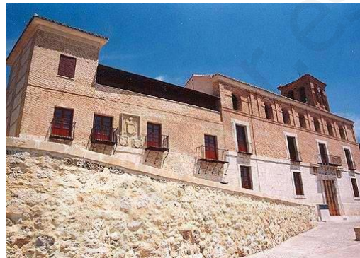
Casas donde se firmó el Tratado de Tordesillas
