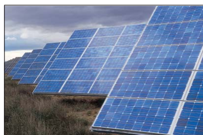
CENTRAL DE PLACAS SOLARES
