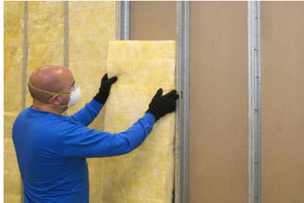
Aislamiento térmico de edificios
