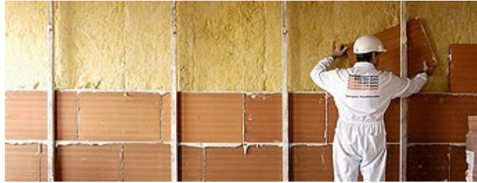
Aislamiento de paredes
