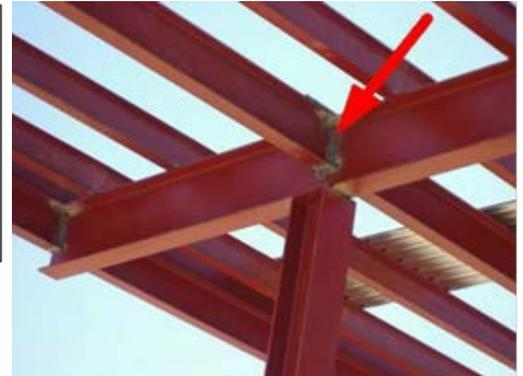
*La zona en que se unen la viga y el pilar sufre cizalladura, porque tiende a cortarse*
