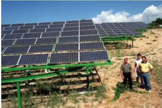
central solar fotovoltaica
